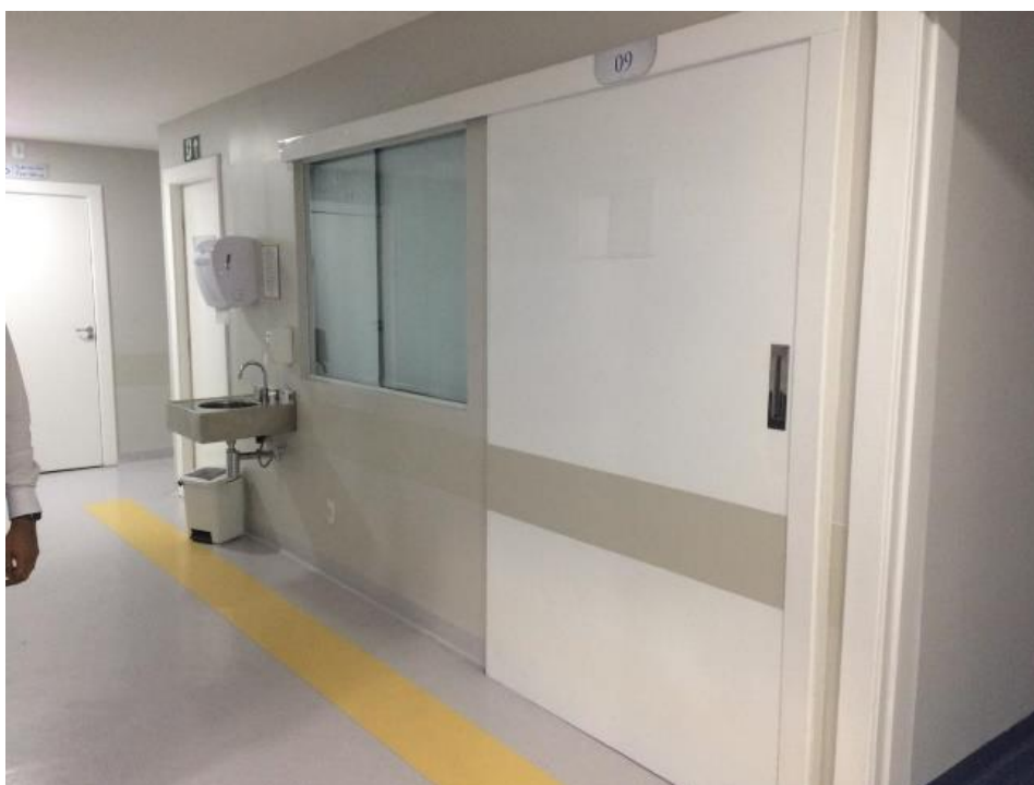
Figura 1. Parte externa do leito da UTI cirúrgica humanizada, individualizado por paredes.
