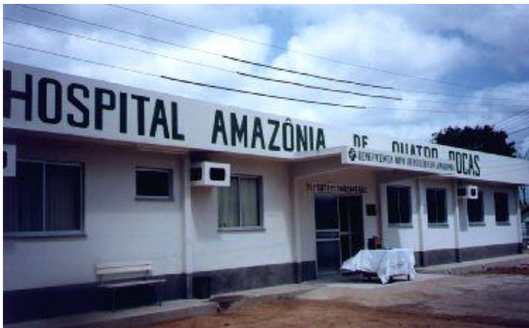
Figura 6. Fachada do Hospital Amazônia de Quatro-Bocas, em Tomé-Açu (PA).
