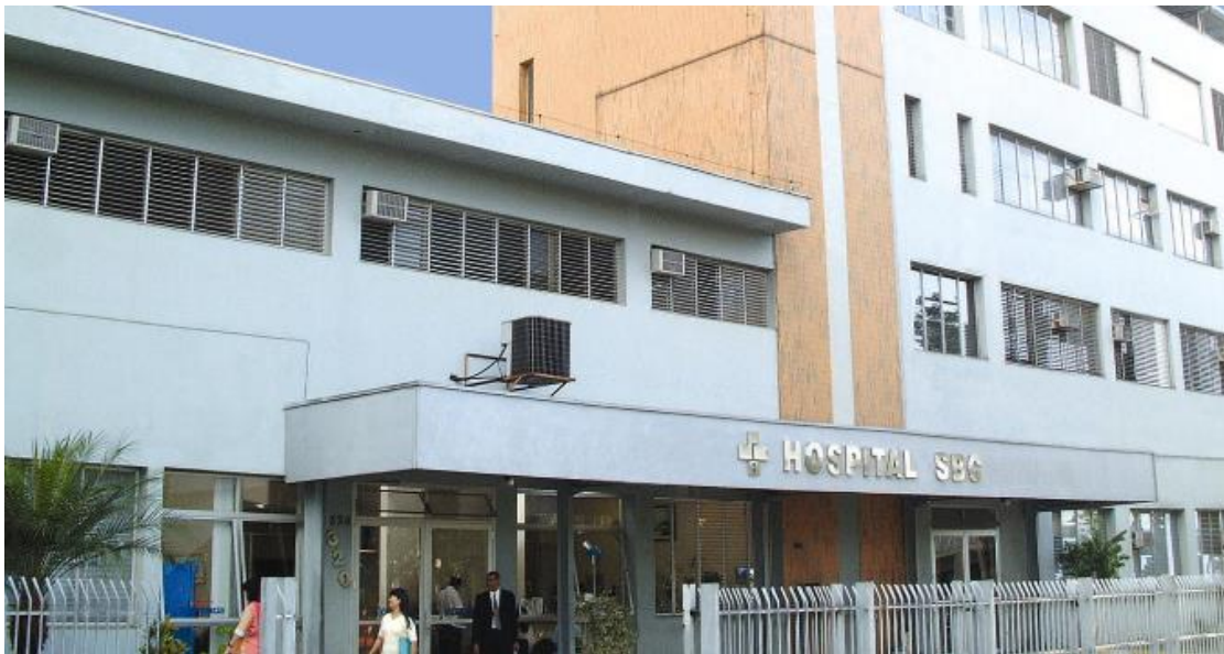
Figura 4. Fachada do Hospital SBC, no bairro da Vila Leopoldina, São Paulo-SP.
